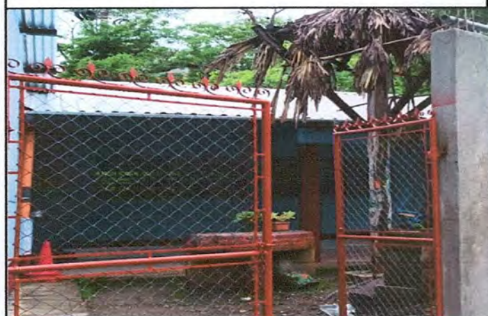
Foto 4: MANTENIMIENTO PINTADO Y CAMBIO DE ENTRADA PRINCIPAL
