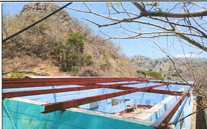
Foto 2: MANTENIMIENTO Y PINTADO DE LAS COSTANERAS
